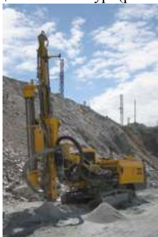
Рис. 37 Буровая установка ROCL6
