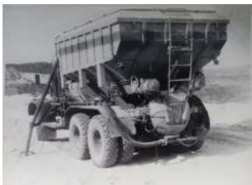
Рис. 11 Смесительно-зарядная машина МЗ-3 (1962 год)
