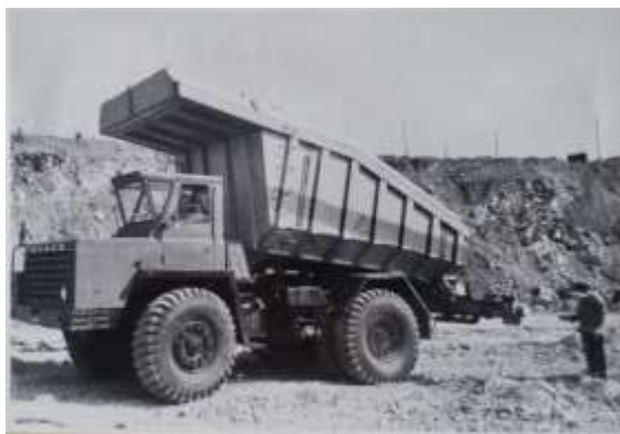
Рис. 16 Зарядная машина МЗ-4 для заряжания скважин игданитом, 1976 год
